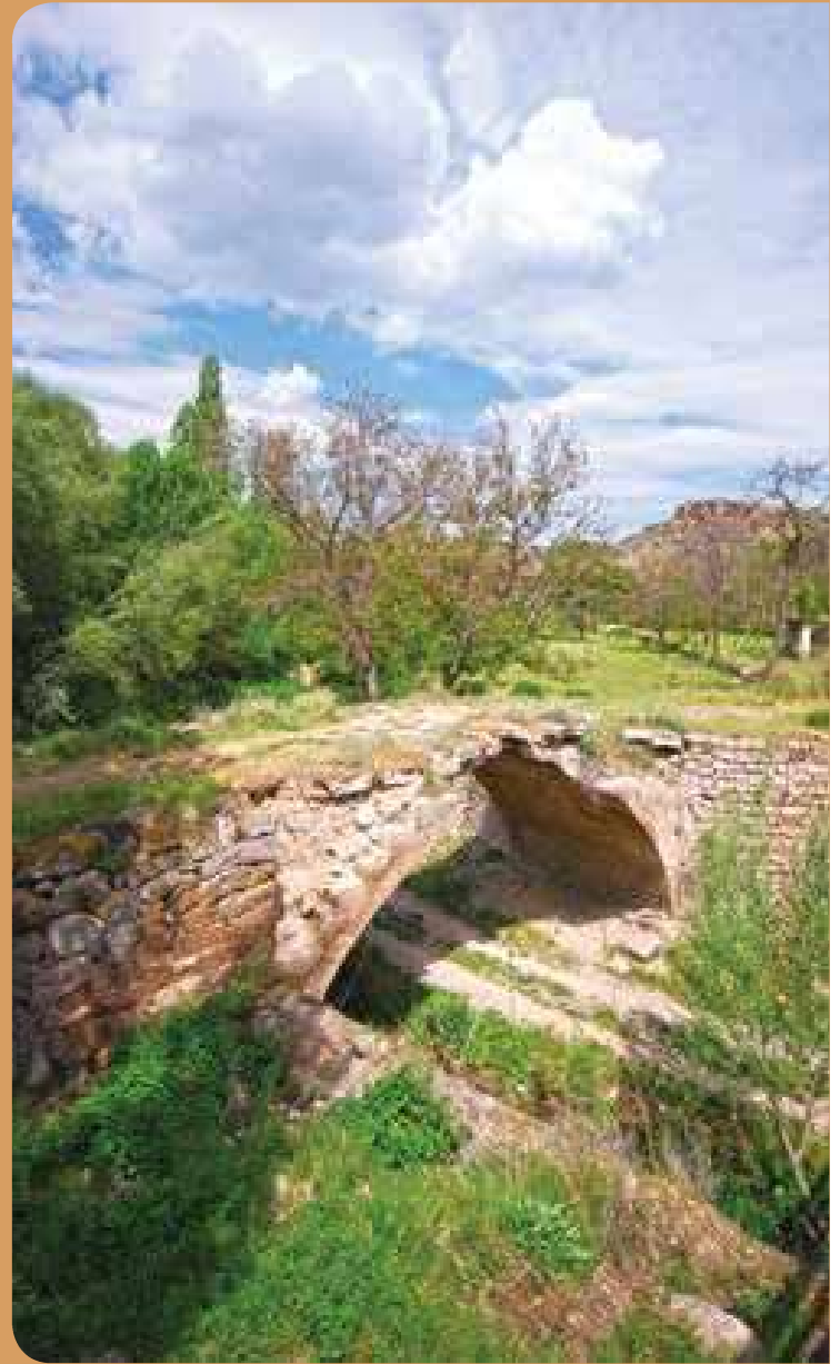
Aşağı Bağpınar Köprüsü, Melikgazi
