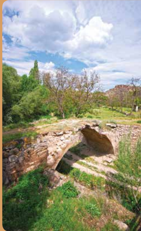
Aşağı Bağpınar Köprüsü, Melikgazi
