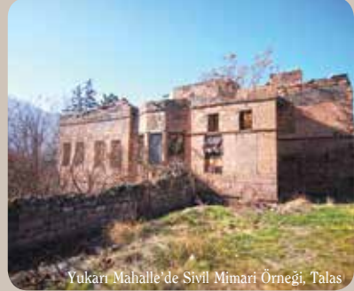
Yukarı Mahalle'de Sivil Mimari Örneği, Talas
